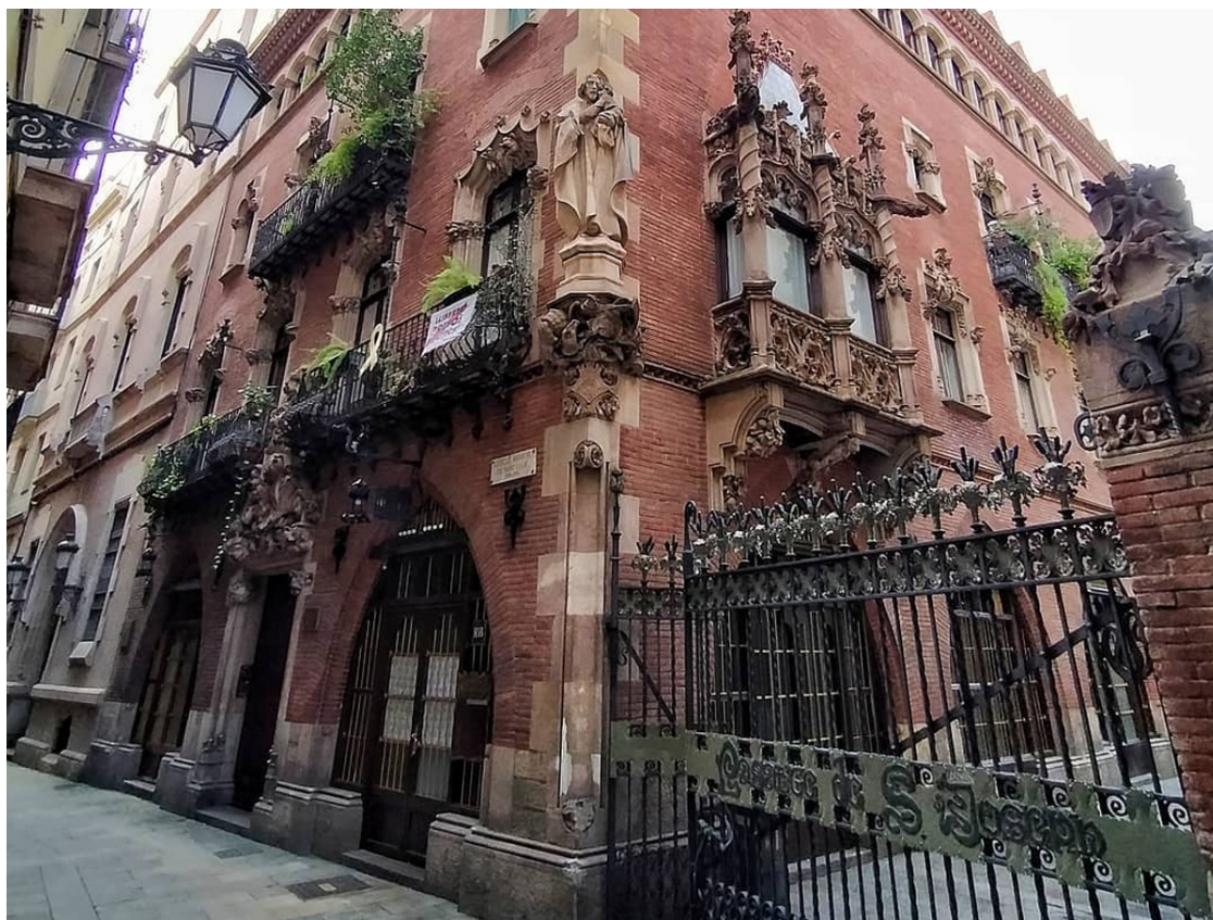
Edifici modernista del restaurant. | Restaurant 4 Gats.
